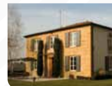
Fabrication de volets isolants www.polyhabitat.fr
